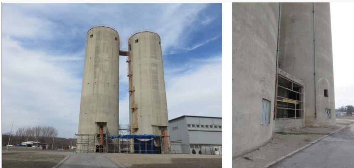
Slika 3 Postojeće stanje silosa
