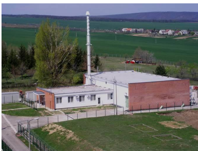
Ulaz u postrojenje deponije, u pozadini je naselje Pušpoksilad
