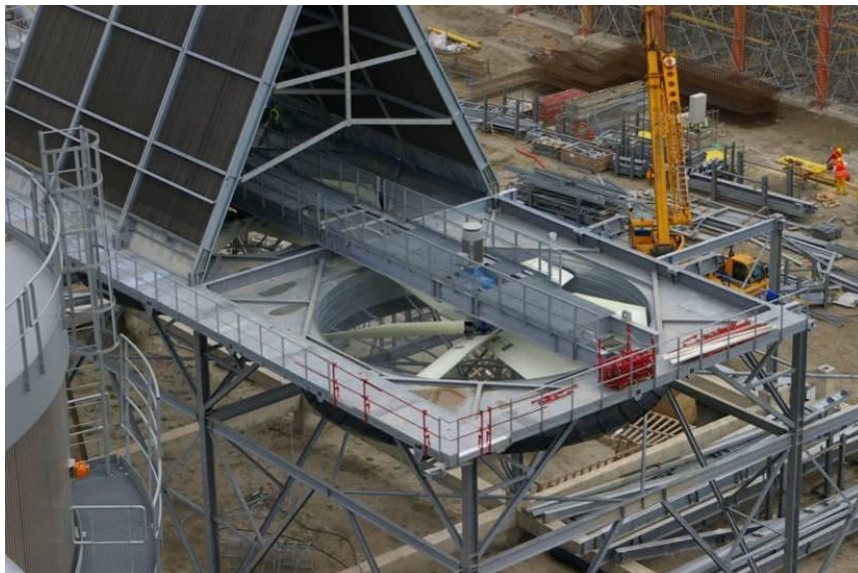
Slika 8. Kondenzator sa vazдушnim hlađenjem
