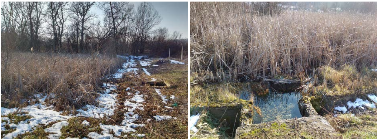
Слика 50. Изглед обрасле растињем лагуна и доводног канала на месту табласте уставе
