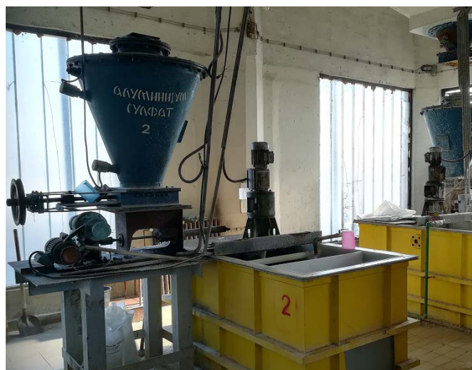
Слика 41. Постојеће каде и дозатор алуминијум сулфата
