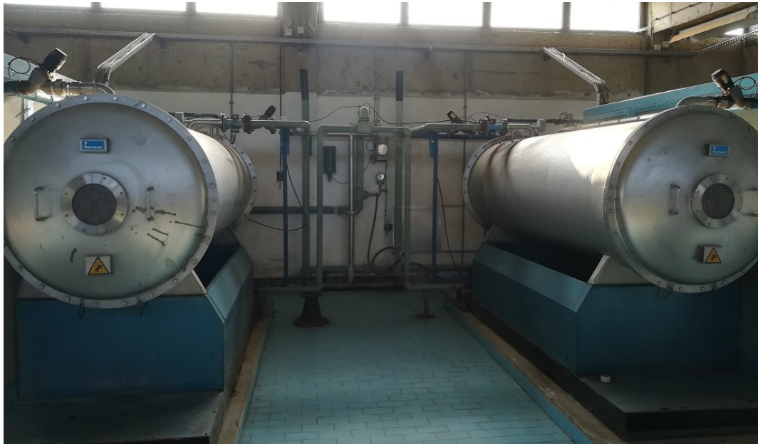
Слика 28. Генератори озона
