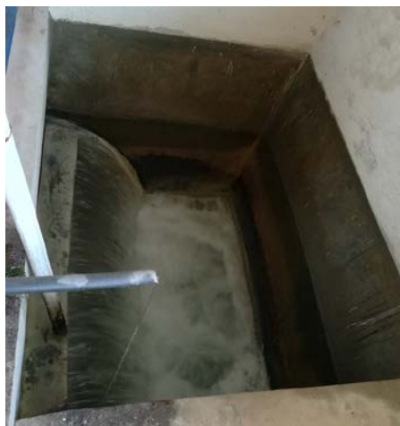
Слика 26. Дозирање полиелектролита у умирујућој комори
