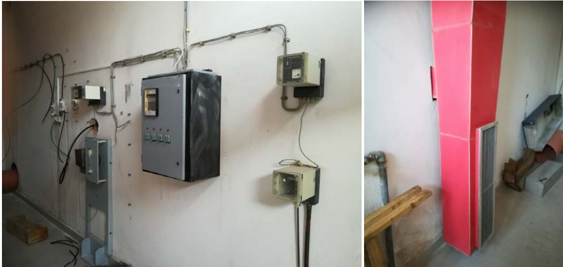
Слика 32. Опрема за заштиту од штетног деловања хлора
