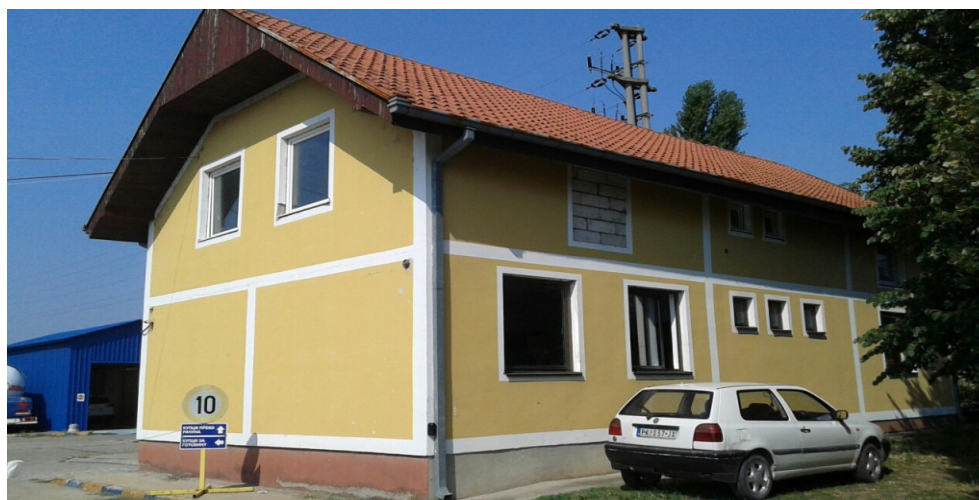
Slika 3.1-3. Objekat predviđen za rušenje, pomoćna zgrada i magacin - Objekat nije legalan
