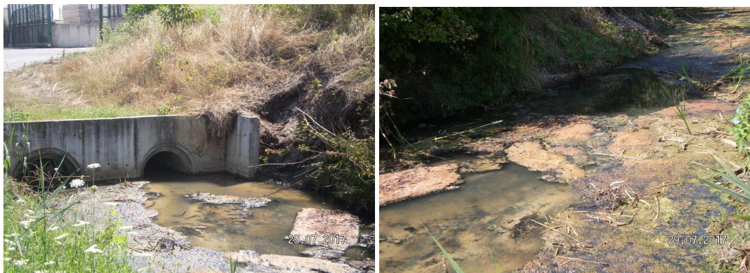
Slika 2.4-2. Meliorativni kanal u neposrednoj blizini, a pre uliva prečišćenih tehnoloških otpadnih voda industrijskog kompleksa "Drenik ND"
