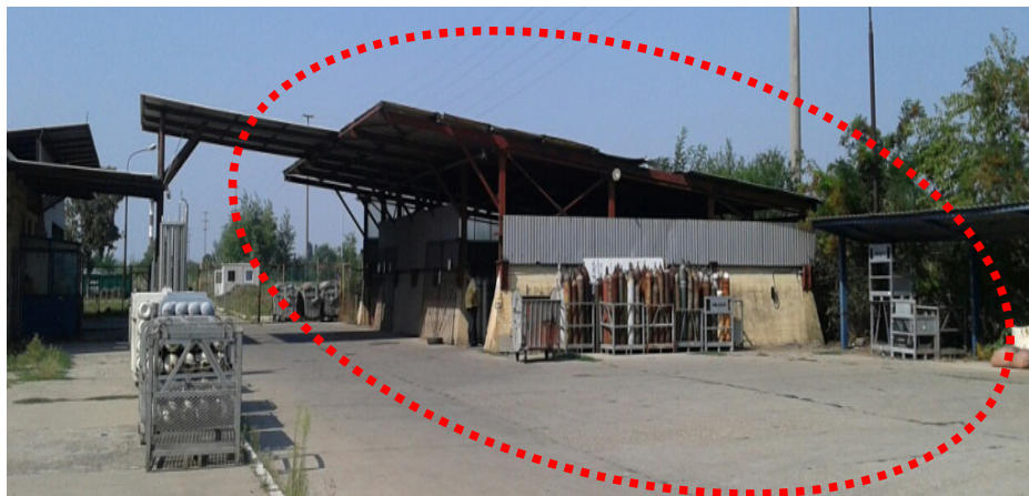
Slika 3.1-1. Privremeni objekti predviđeni za rušenje
