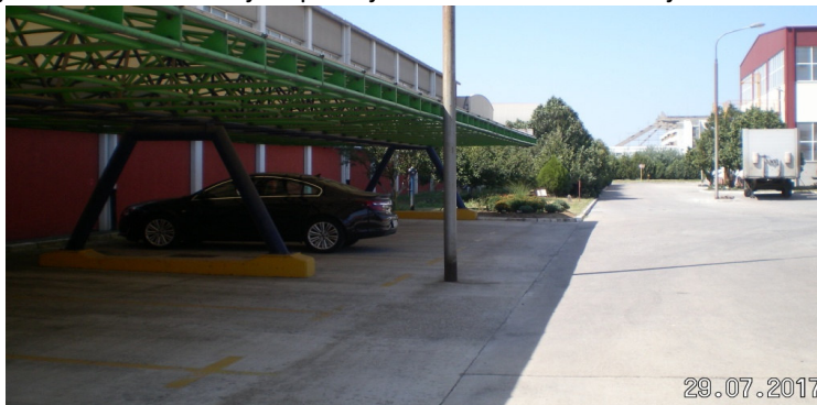
Slika 3.2.7.1-1. Postojeći parking prostor
