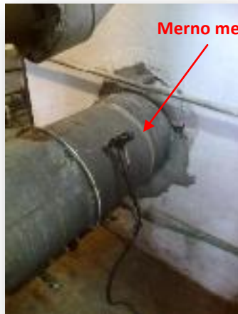
Merno mesto – Emiter kotla na TNG - POGON TNG “BEOGRAD”
