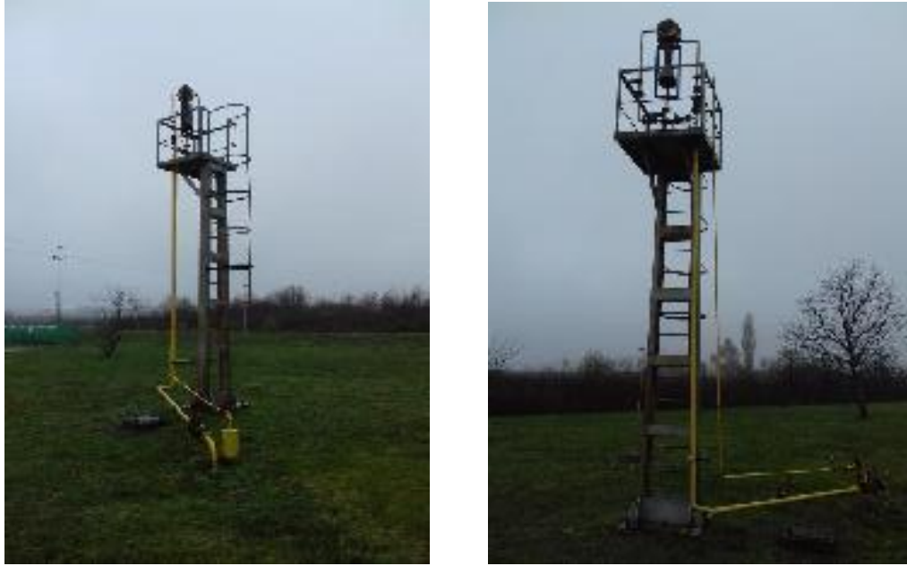
Слика 4. Бакља за спаљивање мртвих залиха (објекат број 11)
