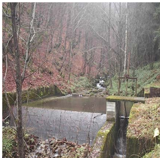
Слика 6.5. Водозахватни објекти водоводног система „Рогавчина“, тзв. „Жељински систем“ са ког се водом снабдева Александрац (Петровић, 2011).
