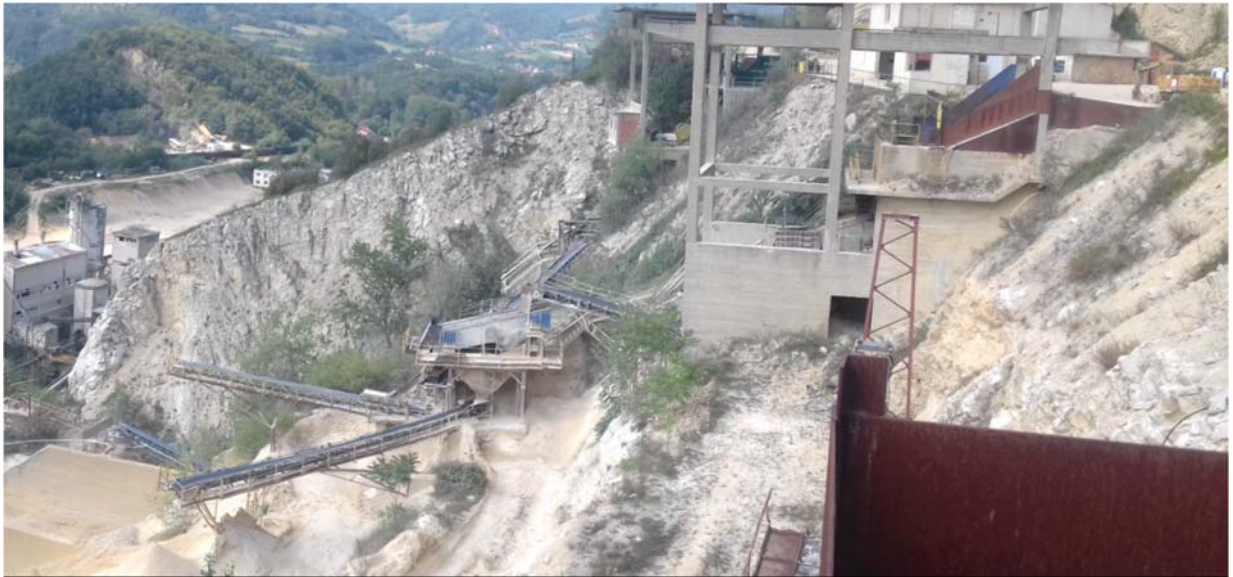
Slika 6. Izgled postojećeg postrojenja
