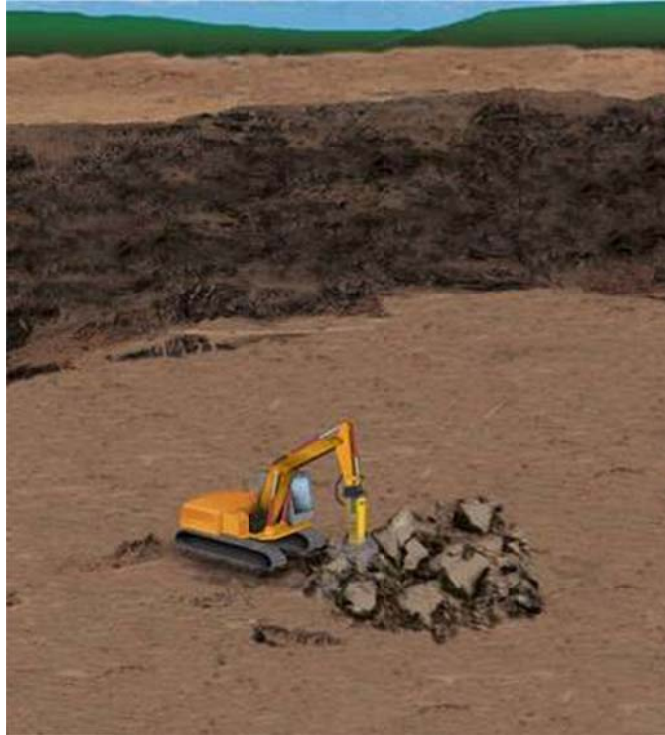
Slika 2.2. Usitnjavanje negabarita mehaničkim udarnim čekićem
