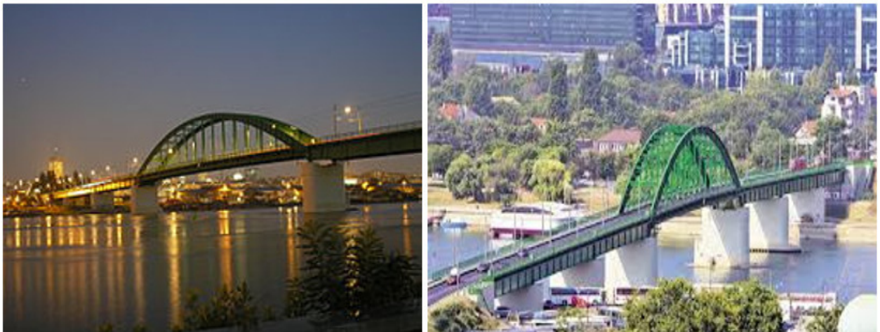
Слика 2.10.2-2. Постојеће стање Стари савски мост
