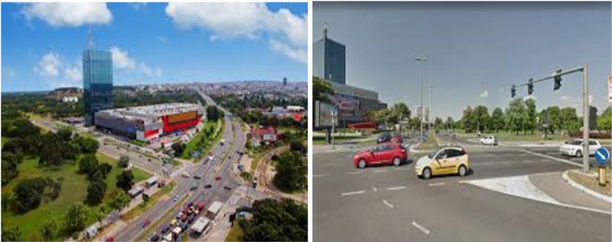
Слика 2.10.2-5. Постојеће стање, улица Земунски пут – Михајла Пупина
