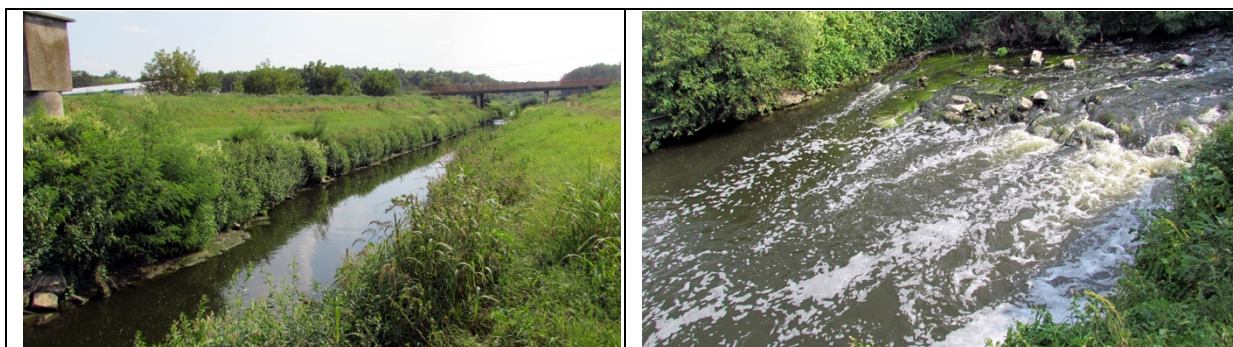
Фотографије локалитета Лепеница – Лапово село (мост на аутопуту Београд – Ниш).
