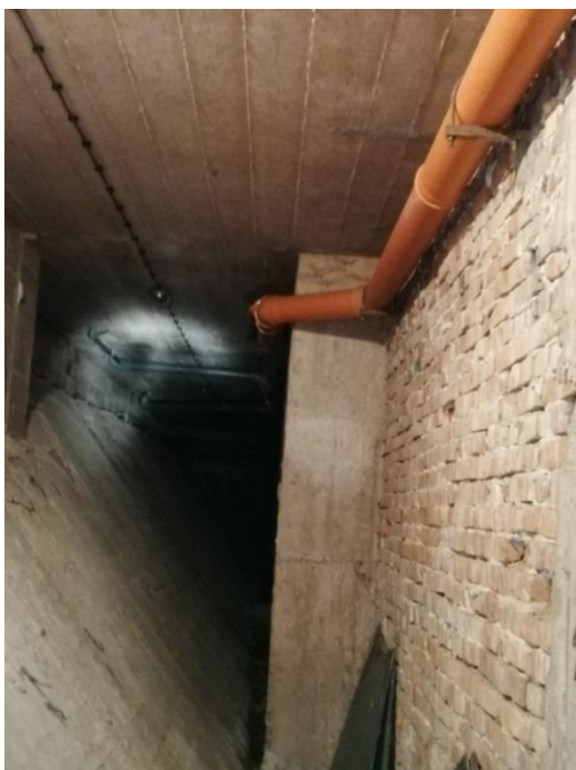
Слика 2: Главна канализациона цев на локације галерије 3
