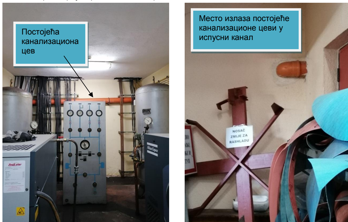
Слика 4: Главна канализациона цев – место излаза из машинске зграде у испусни канал
