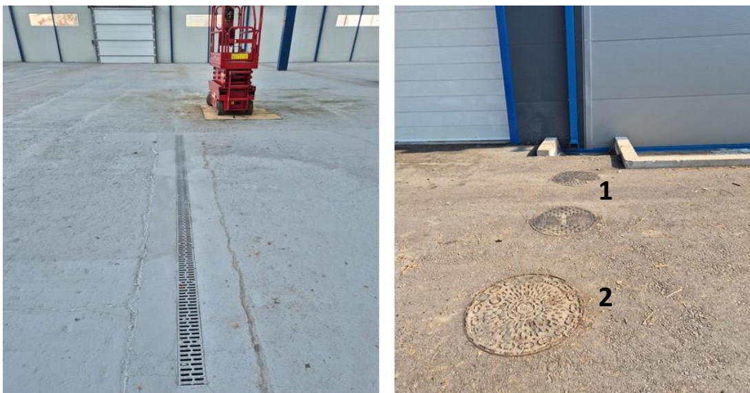
Слика 7. Подни канал и шахт од сепаратора (1) и интерне канализације (2)
