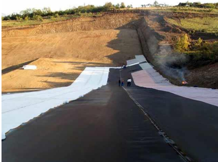
Слика 10. Постављање заштитне фолије на тело депоније
