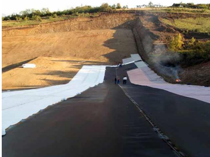
Слика 5. Постављање заштитне фолије на тело депоније
