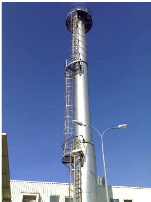
Слика 9. Емитер поликондензационе коморе
