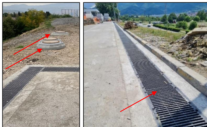
Слика 14. – Уграђен први сепаратор масти и уља од 14. августа 2021 (лево) и изградња канала за прикупљање атмосферске воде 10. јула 2021 (десно)
