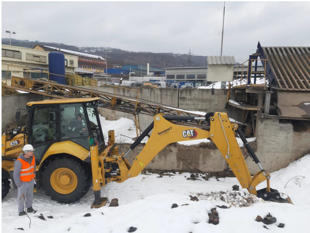
Слика 2: Механизација коришћена за ископ истражних јама
