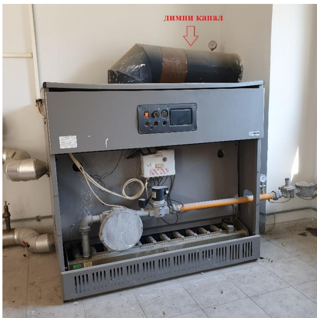
Слика 10а. Заједнички димни канал
