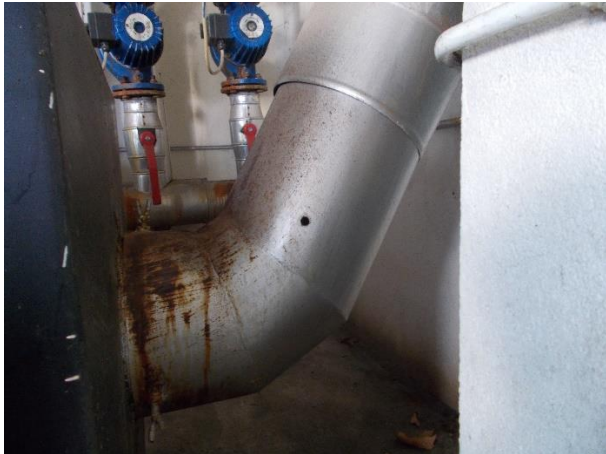
Слика 11а. Димни канал са мерним местом
