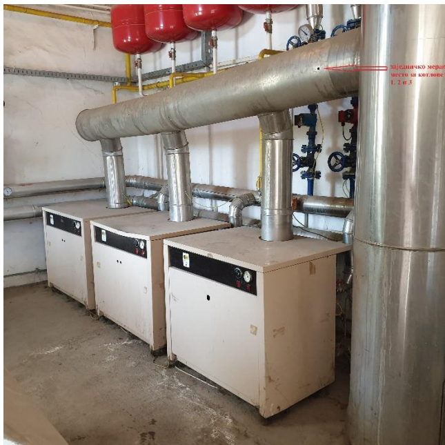
Слика 8а. Заједнички димни канал
