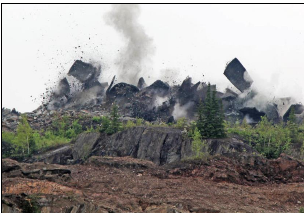
Слика 17. - Минарање применом тешких заштитних прекривки (ниједан комад одминеране стене не лети на велике даљине, одминирани материјал остаје 5 m од минског поља)
