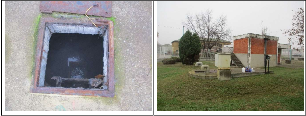
Sabirna jama pre ispuštanja u kanalizaciju
