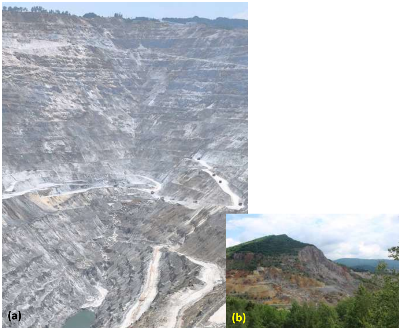
Slika 3.2 – Izgled površinskog kopa Južni revir: pogled sa severne strane (a) i pogled sa južne strane (b) (Andezitski prst i Plumberija)
