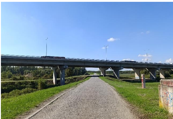
Слика 3.10 – Насип код Остружничког моста
