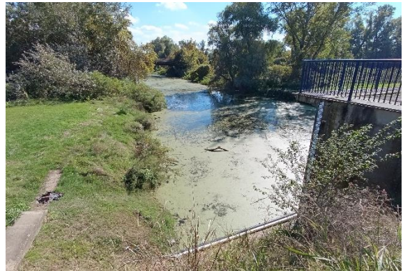
Слика 3.9 – Одводни канал црпне станице „Галовица“
