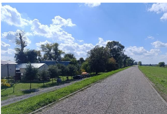
Слика 3.6 – Постојећа сервисна саобраћајница по круни насипа
