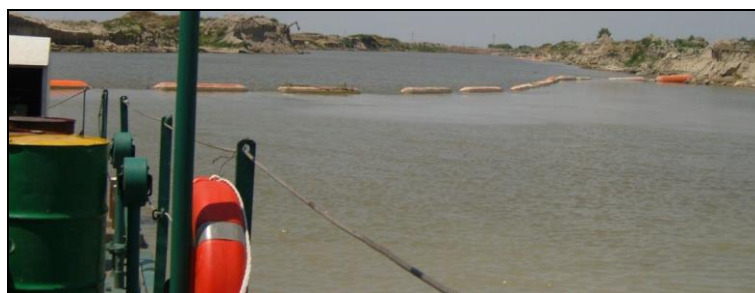
Slika 14. Cevovod za transport peska
