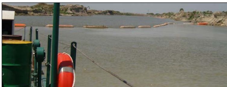
Slika 11: Cevovod za transport peska
