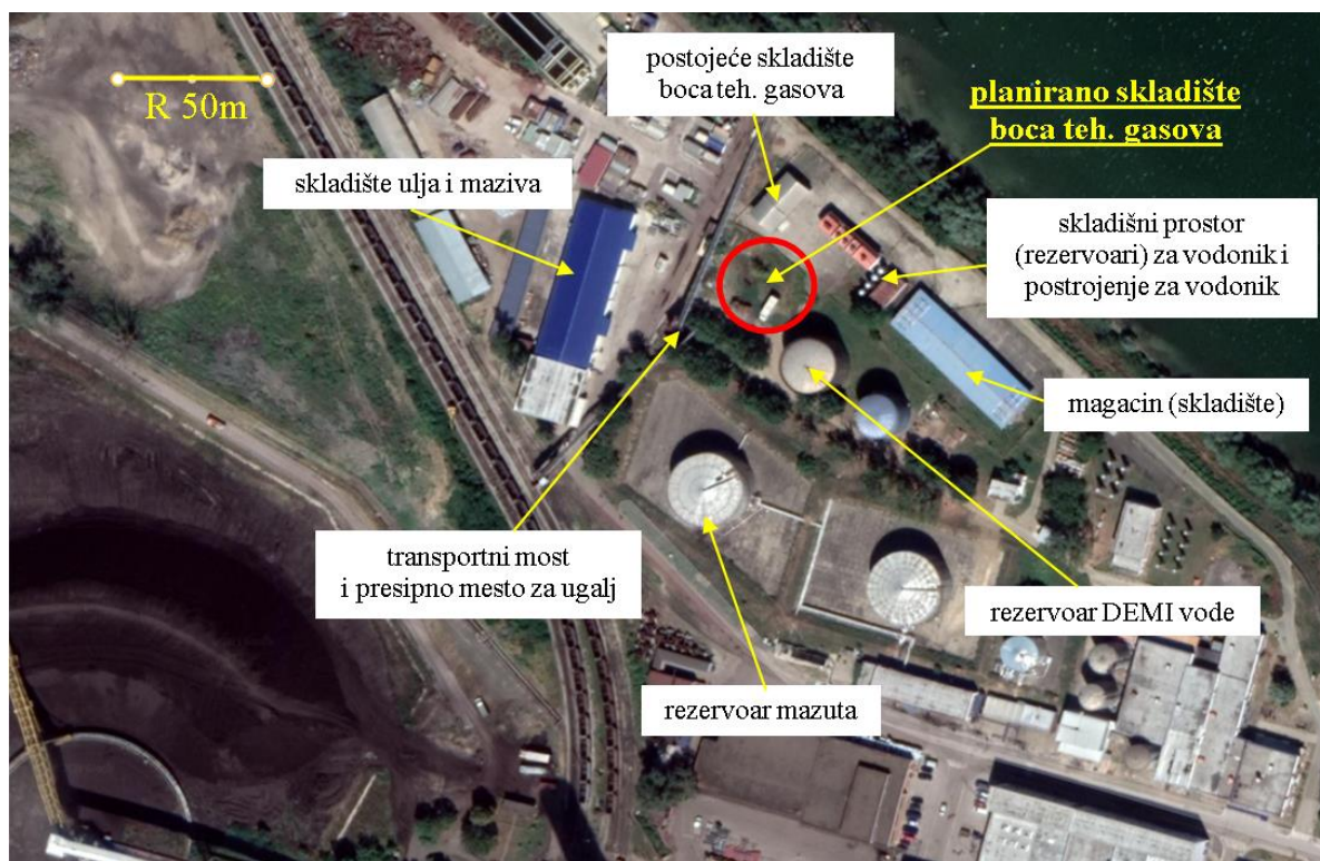
Slika 2. Skladište boca tehničkih gasova – Mikrolokacija (R=50 m)
