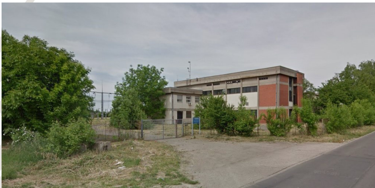
Слика 2-3 : Трансформаторска станица ТС 110/35 kV „Београд 9“
