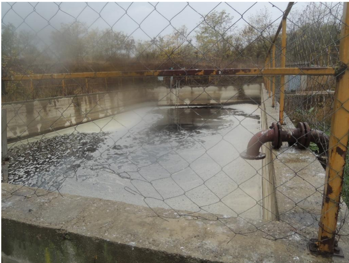
Слика бр.10: Лагуна за третман процедних вода на постојећој депонији „Метерис“
