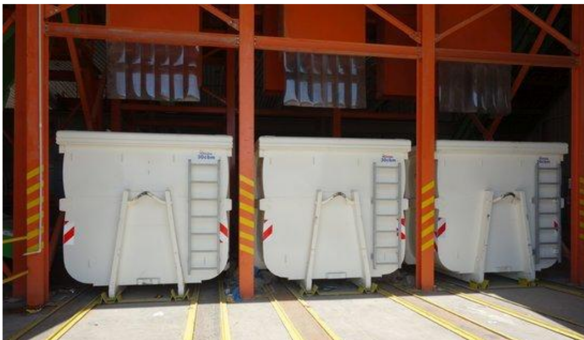
Слика бр.17: Падајуће испусне цеви које се завршавају изнад контејнера за рециклажни материјал
