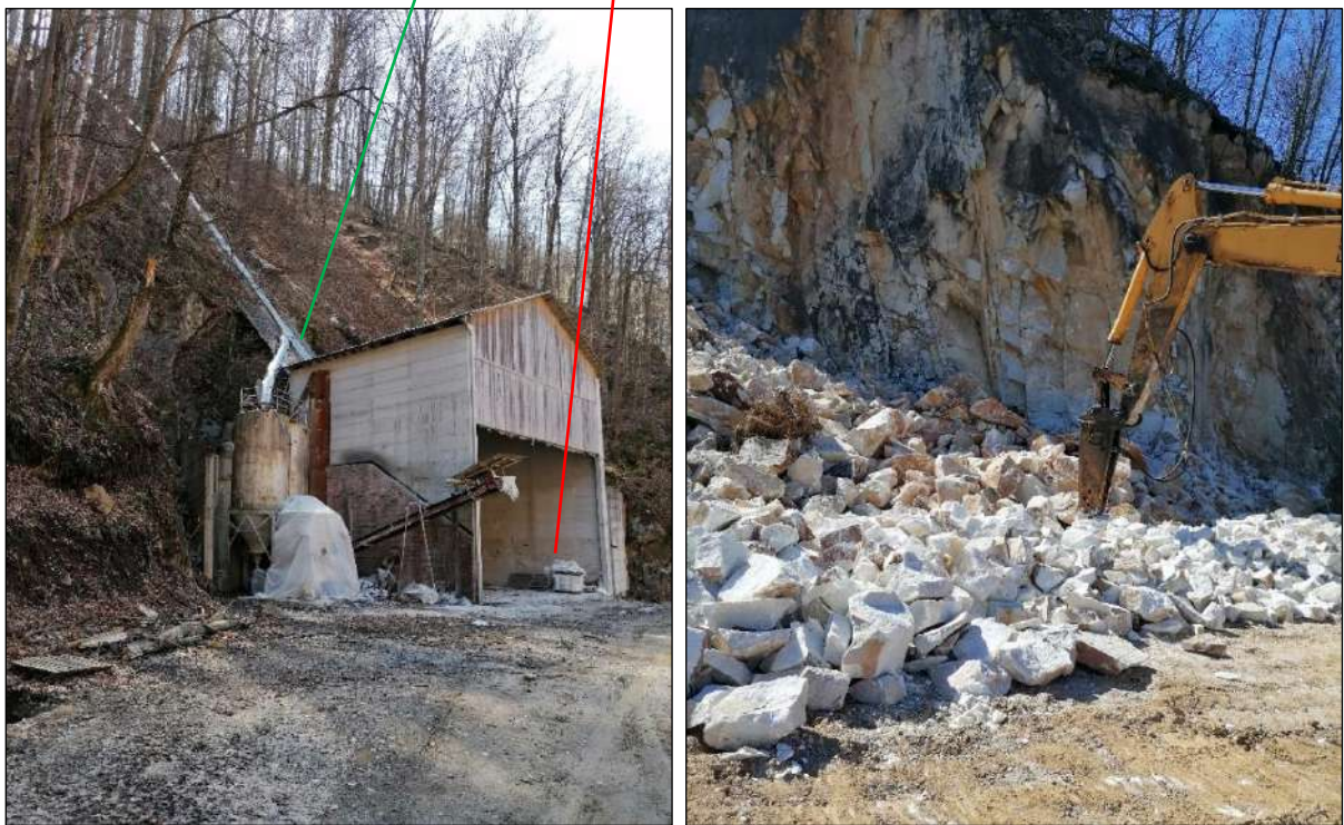
Слика 8. – Бункер за издробљени материјал постављен на регулисаном делу приступне саобраћајнице – постојећи шумски пут (лево) и отворена етажа ПК мермера „Чот“ (десно)
