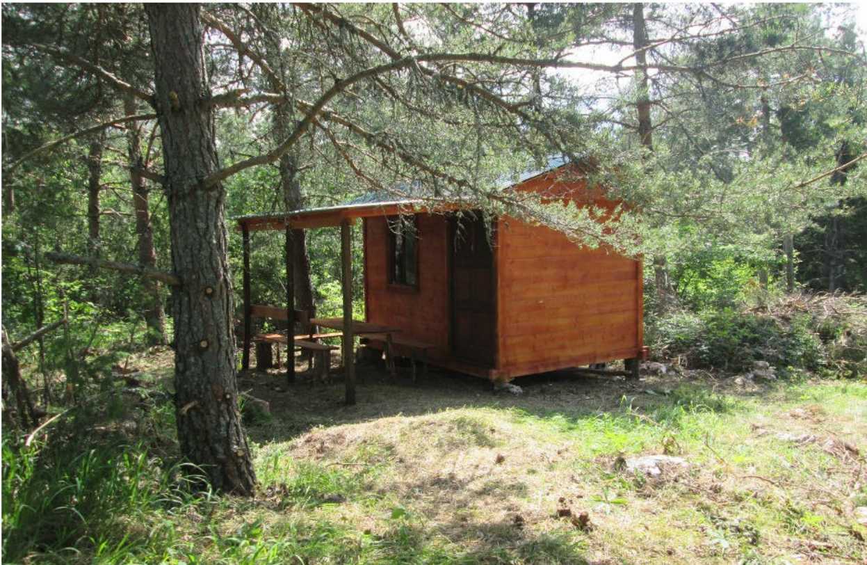
Видиковац „Лопиже” (објект изграђен без грађевинске дозволе), фото: Д. Петраш
