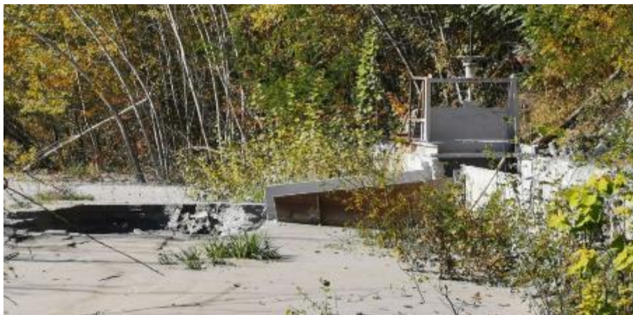
Слика 4.4. Испуст на бетонском каналу након бране „Ванчев поток“
