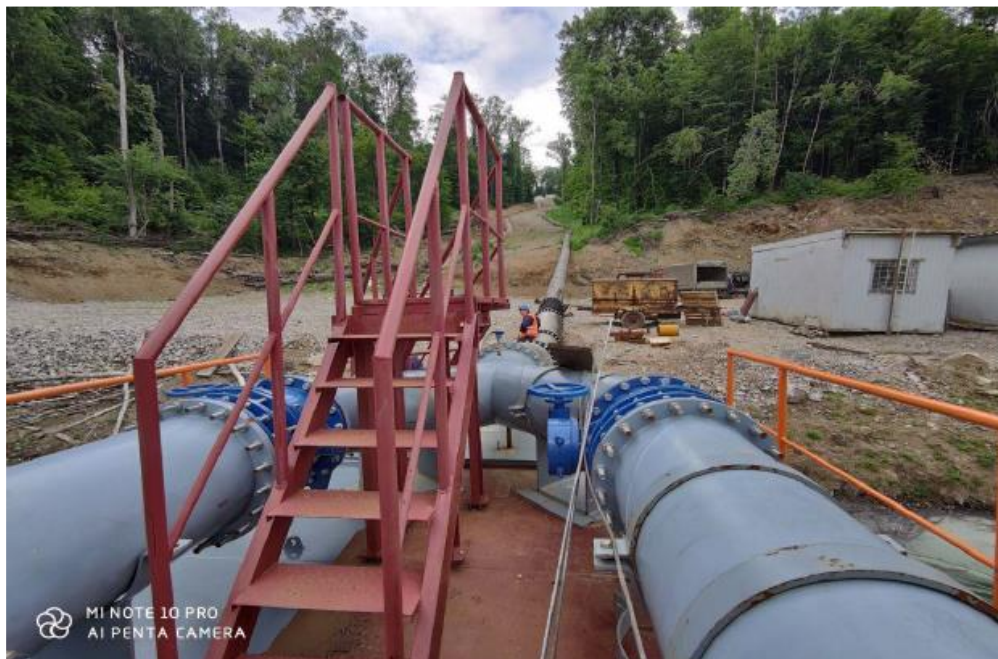
Слика 4.25. Место спајања леве и десне линије цевовода
