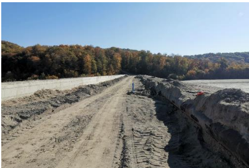
Слика 4.18. Поглед на круне бране „Превој Шашка“ на коти К+537 тпв и ново уграђени пијезометар, 2019.
