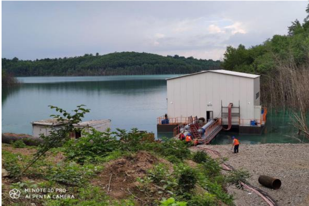
Слика 4.24. Нова ППС2 постављена на пројектовану локацију
