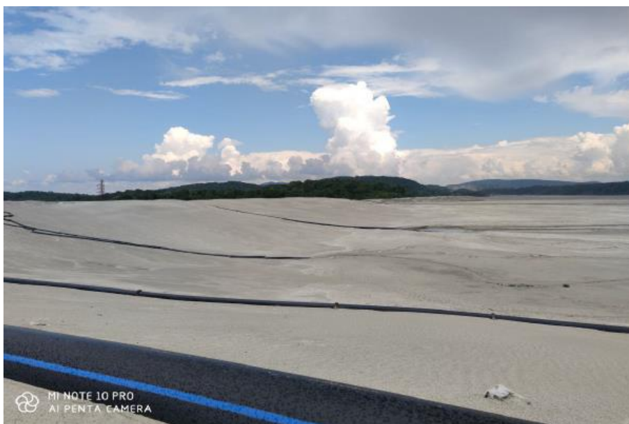
Слика 4.29. Истакачи за одржавање ширине плаже испред бране Калуђерица, јун 2020. год.
