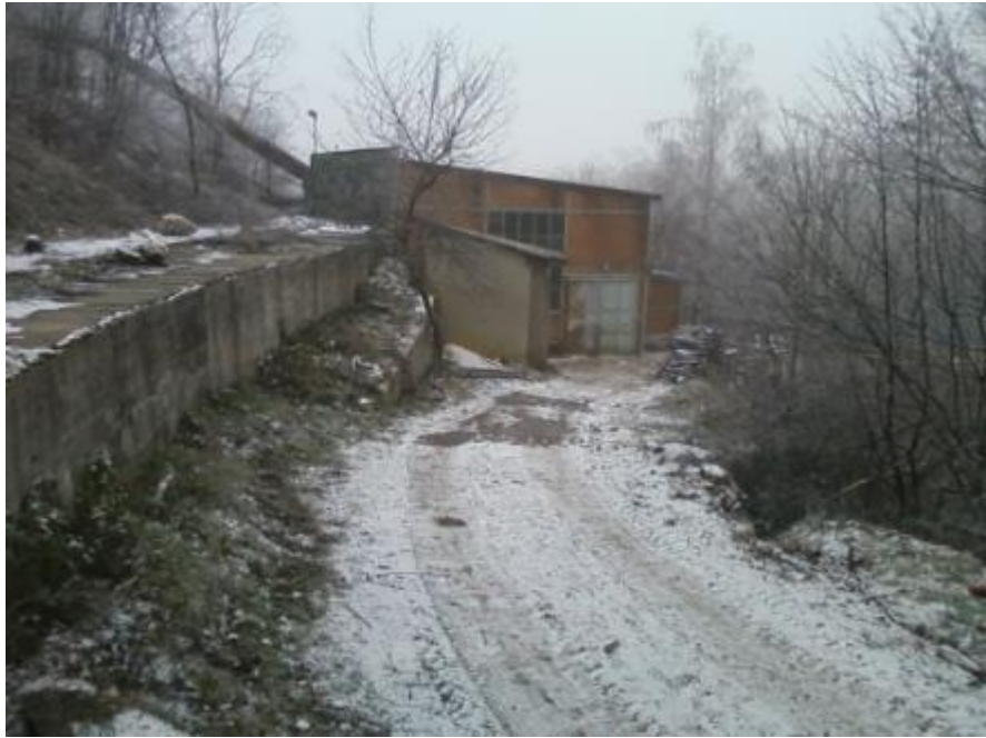
Слика 4.1. Пумпна станица ПС2
