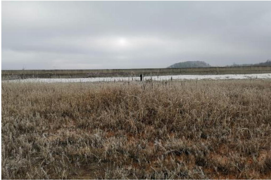
Слика 4.15. Поглед са спољашње косине бране „Пустућац“ у правцу бетонске бране, 2020. год.
