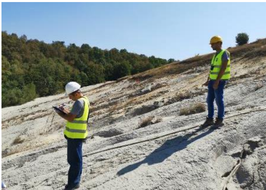
Слика 4.10. Дејство ерозије воде и ветра на спољашњу косину бране, септембар 2019. године
