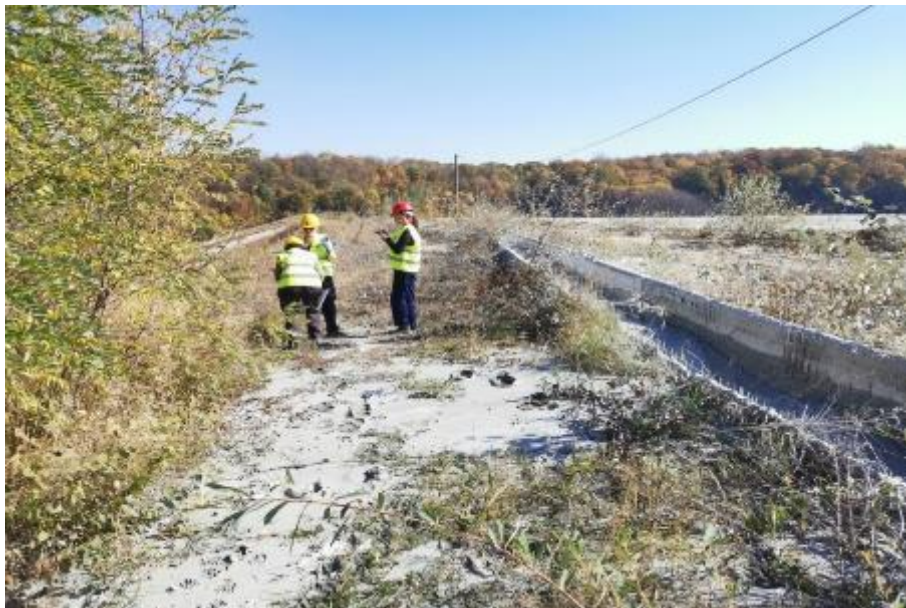
Слика 4.2. Бетонски канал за гравитацијски транспорт јаловине од ПС2 до ПС „Калуђерица“
