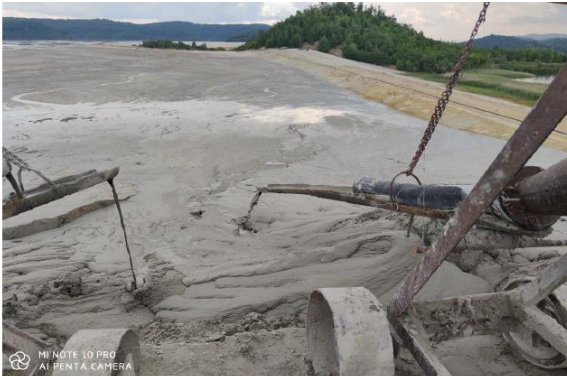
Слика 4.27. Типичан пример директне уградње песка, ХЦ на брани Пустинџац 1, снимљени у раду јуна 2020. године
