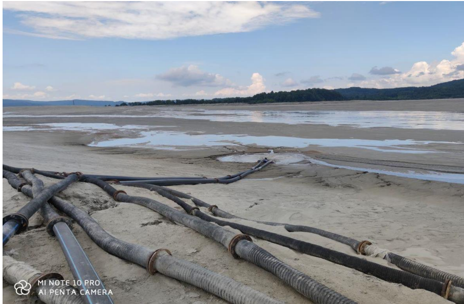
Слика 4.28. Одлагање муља хидроциклона иза фронта напредовања бране, брана Пустуњац I, јун 2020. године
