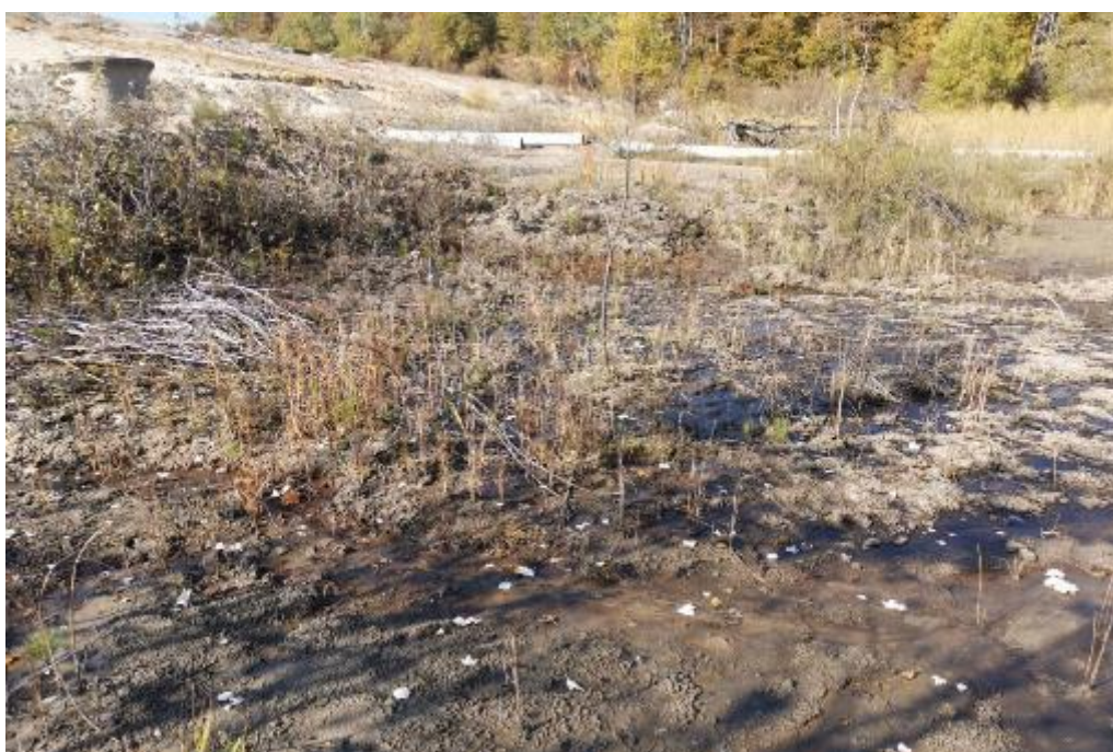
Слика 4.19. Фронт процеђивања на спољашњој косини „Превој Шашка“
