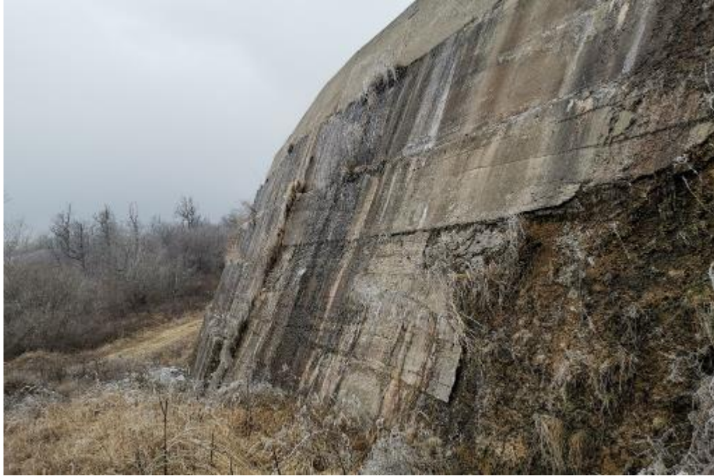
Слика 4.17. Оштећења на спољашњој косини бетонске бране, јануар 2020. године
