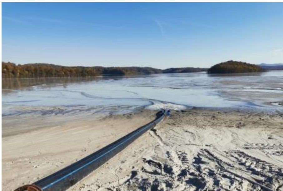
Слика 4.6. Одлагање муља и формирање плаже, 18.10.2019.
