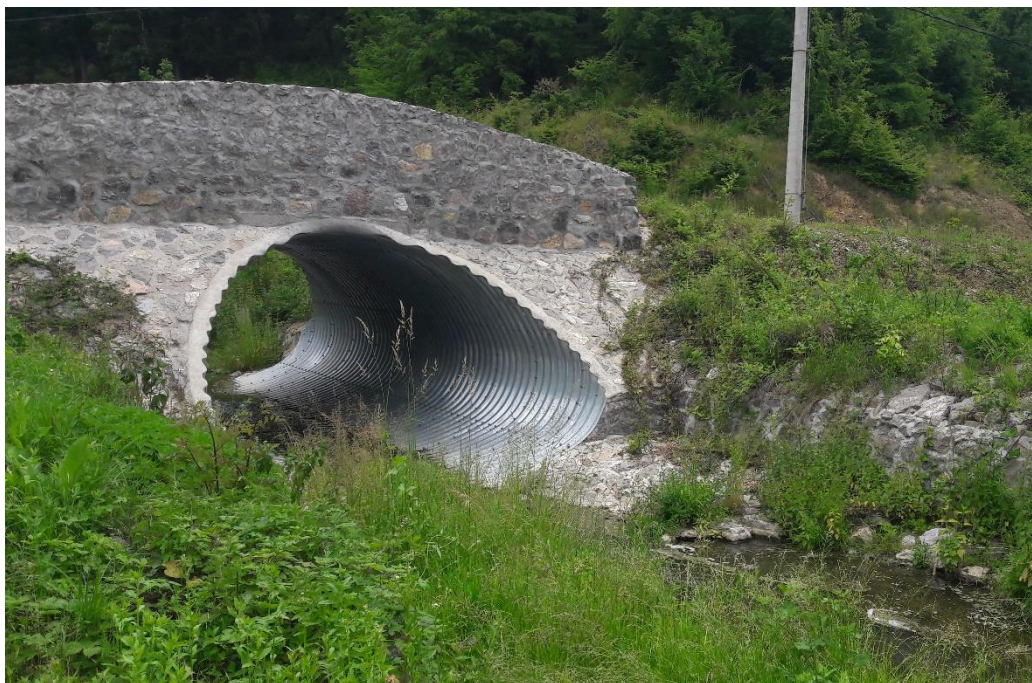
Slika 2-11. Most na Ražanjskoj reci
