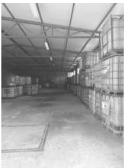
Slika 13. Unutrašnjost skladišta za smeštaj opasnog otpada
