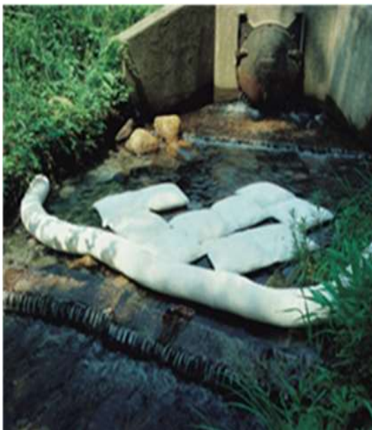
Slika 8.2 – Sakupljanje prosutog ulja iz vodotoka
