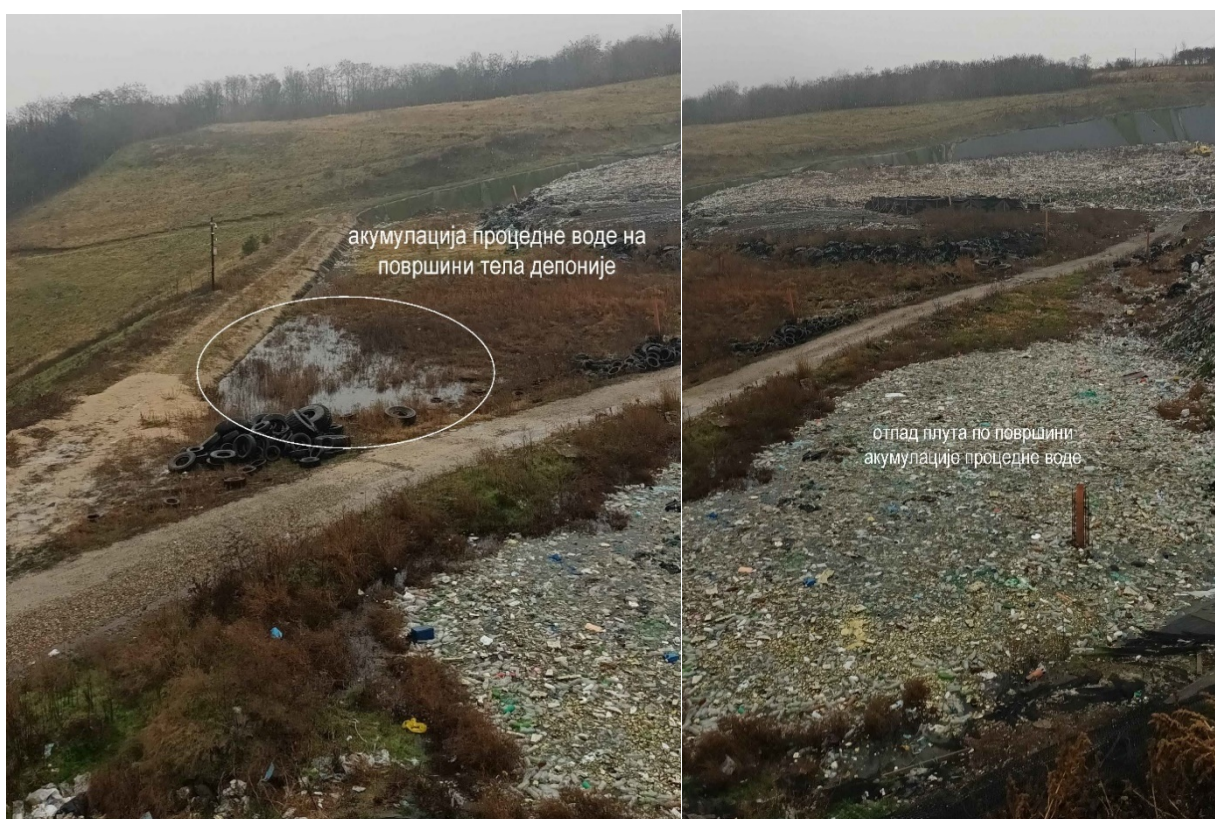
Слика 7.5. 8. Поглед на акумулирану процедну воду на телу депоније фазе 1
