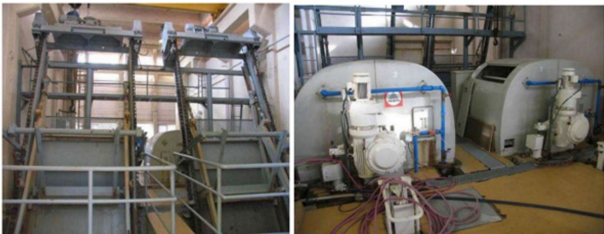
Слика 3.5: Аутоматске грабуљасте fine решетке (лево) и механичка сита (десно)
