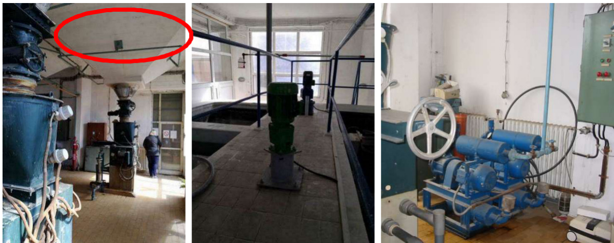
Слика 3.7: Систем за припрему раствора алуминијум сулфата: силос, суви дозатор, каде са алуминијум сулфатом и компресор
