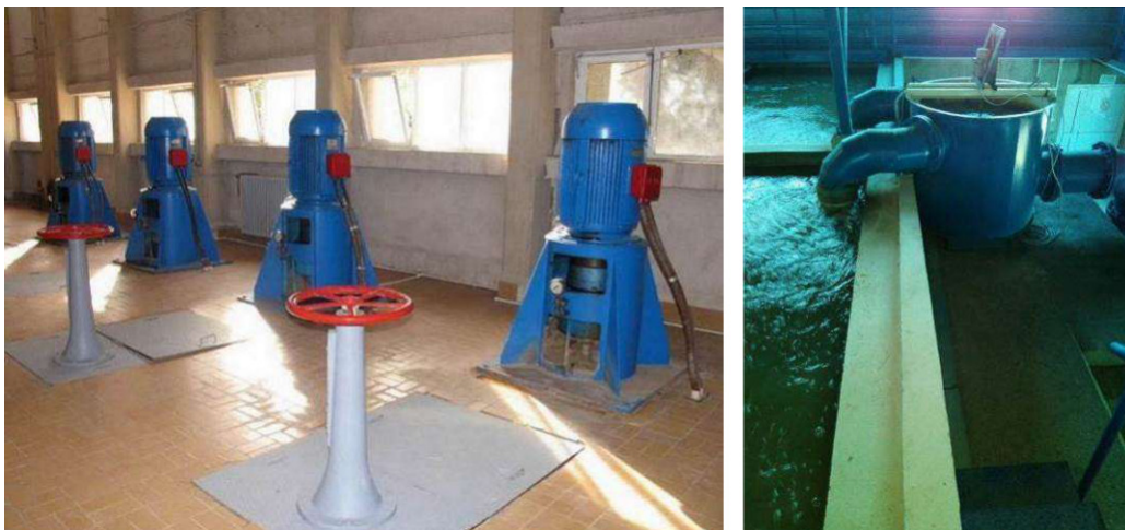
Слика 3.6: Пумпна станица сирове воде и брзи мешач у који пумпе потискују сирову воду
