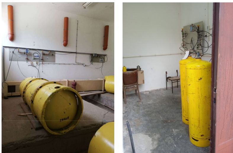
Слика 3.21: Опрема за дозирање гасног хлора на ПС Медијана 2 (лево) и Медијана 1 (десно)
