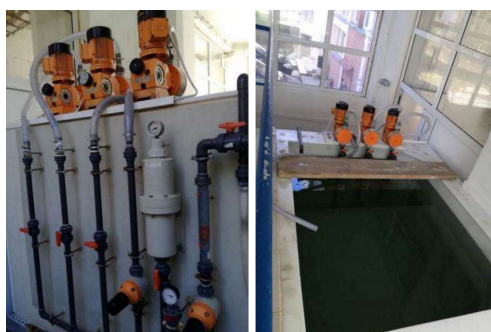
Слика 3.8: Опрема за дозирање алуминијум сулфата
