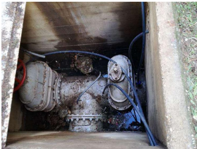
Слика 3.9: Дозирање алуминијум сулфата у цевоводу
