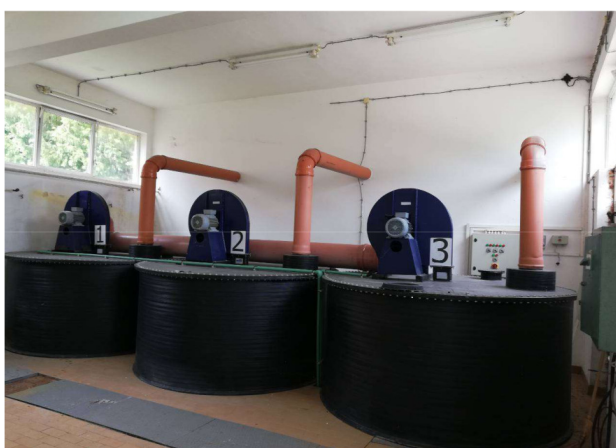
Слика 3.22: Опрема за неутрализацију гасног хлора
