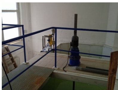
Слика 3.10: Опрема за дозирање полиалуминијум хлорида (БОПАК-а)
