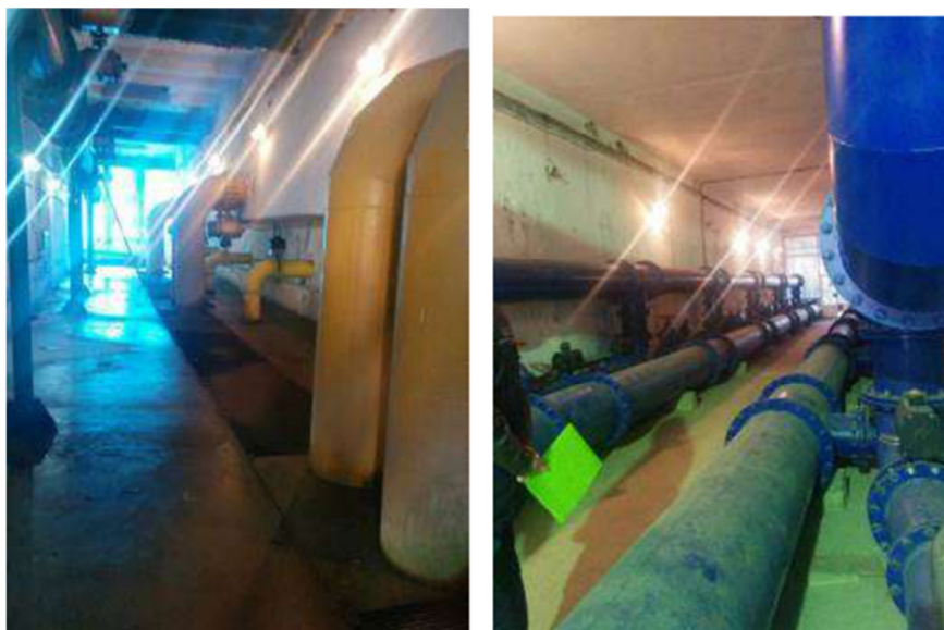
Слика 3.14: Цевна галерија воде од прања филтера и цевна галерија чисте воде
