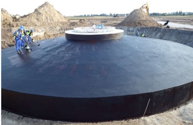
Пример темељења стубова ветрогенератора
