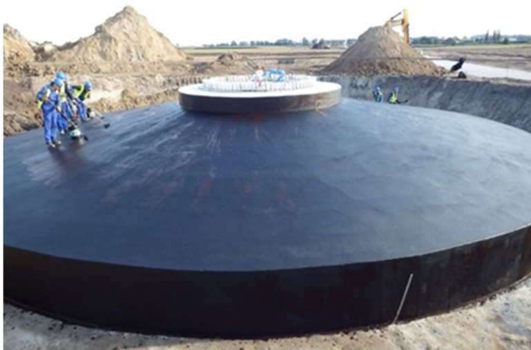
Слика 3.4. Пример темељења стубова ветрогенератора
