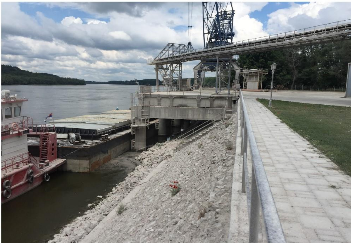
Slika br. 30: Postojeća kejska konstrukcija
