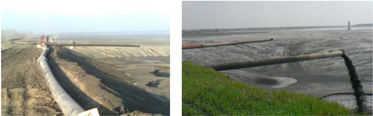
Слика 17: Систем за истакање хидромешавине пепела и шљаке у касети 2
