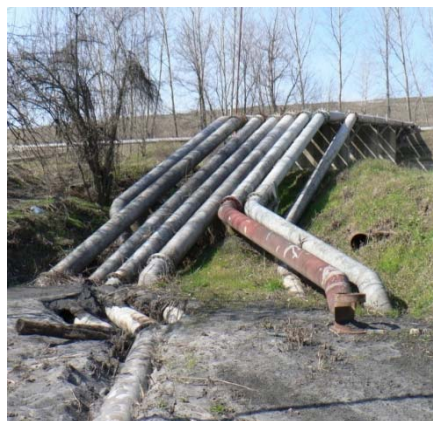
Слика 14: Магистрални челични цевовод за транспорт пепела и шљаке до депоније ТЕНТ А
