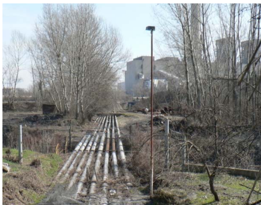
Слика 14: Магистрални челични цевовод за транспорт пепела и шљаке до депоније ТЕНТ А
