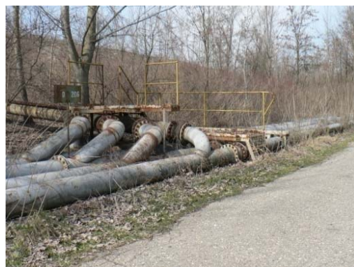
Слика 16: Дистрибутивни челични цевовод за транспорт пепела и шљаке по депонији ТЕНТ А са стране канала
