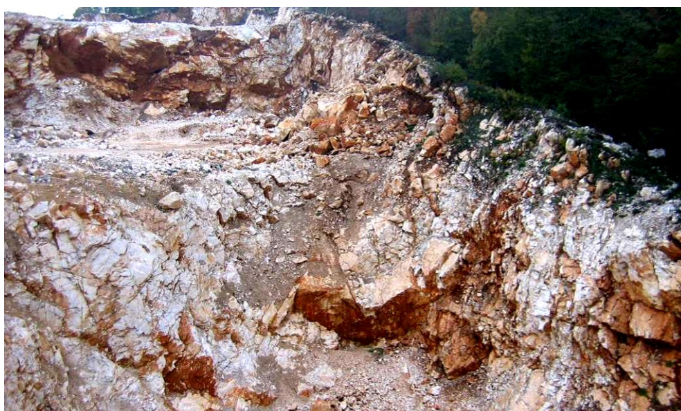
Slika 7 . Rupturni elementi u ležištu „Kameniti Vrh - Albatros“.
