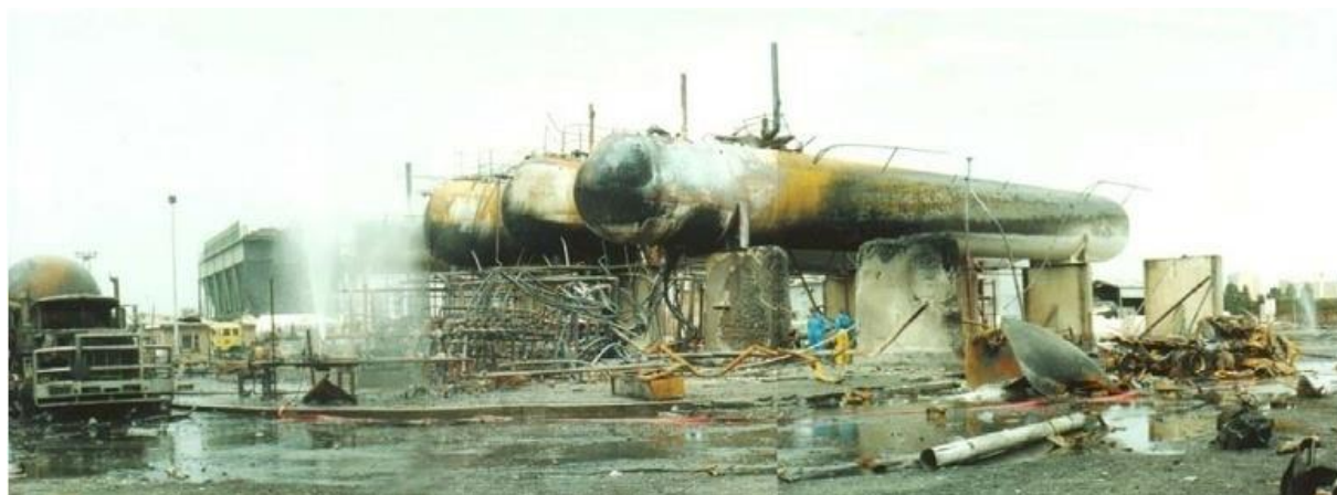
Slika 9.: Skladište TNG nakon eksplozije. Na slici se vidi postolje rezervoara br. 1 koji je odleteo u obližnji kanal
