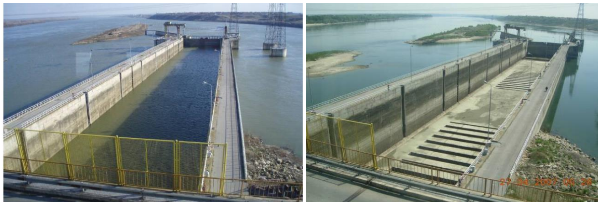
Слика 4.4 - Бродска преводница у погону и празна комора бродске преводнице
