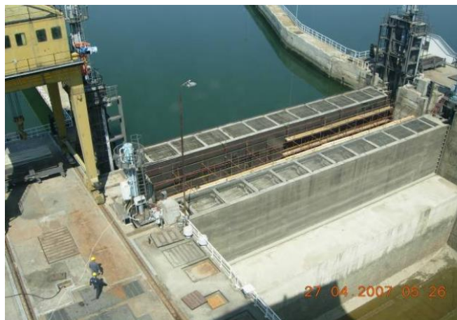
Слика 4.3 - Горња глава са радним и хаваријско-ремонтним вратима
