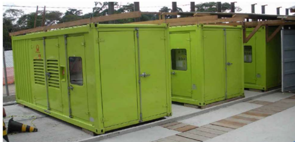
Slika 7.2.5b. Generator set montiran u kontejner
