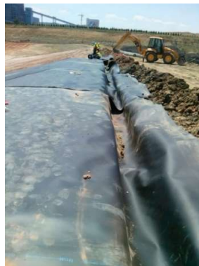
Slika 5.2.1. Detalj ankerisanja folije na nasipu
