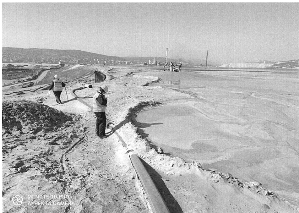
Slika 13. – Nasip između brane 2 i ploveće pumpne stanice koji nema potrebnu visinu i projektovanu širinu od 8 m,
