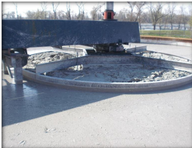
Слика 31. Централни део радијалног коагулатора – сакупљање лаке фракције са површине воде
