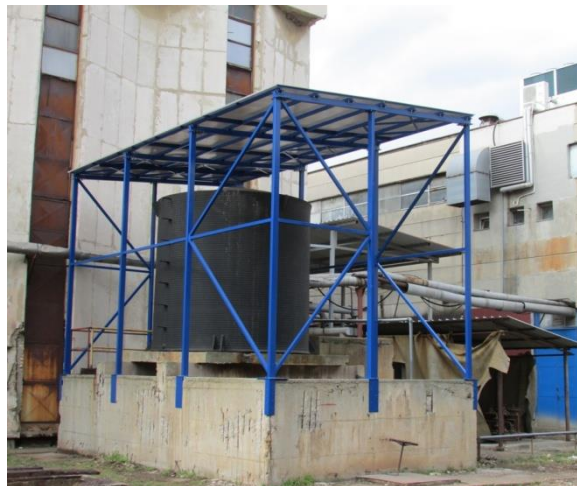
Слика 22. Резервоар за складиштење хлороводоничне киселине (HCl)
